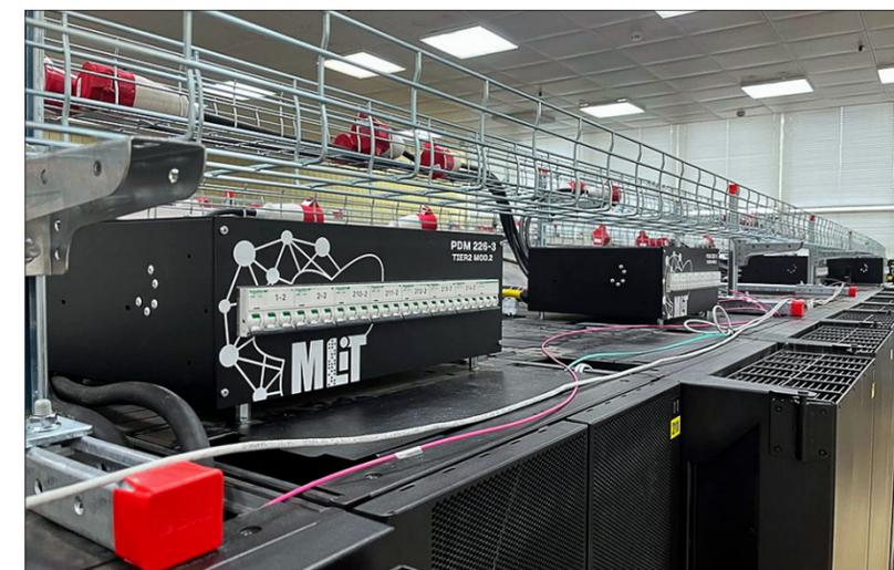
нером ЛИТ Андреем Евлановым. Сборка, монтаж и подключение PDM для 1-го и 2-го модулей МИВК были проведены в конце 2024 года. Установлены и введены в эксплуатацию шкафы гарантированного питания от источников бесперебойного питания Galaxy 7000, смонтировано по восемь PDM в каждом модуле. Была начата подготовка подключения трехфазного питания к PDM. Позже, в марте-апреле, 1-й и 2-й модули в первую очередь были полностью переведены на трехфазное электропитание.
