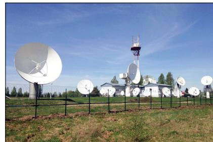
никовой сети связи компании «Истар» на оборудовании УНР, которые обеспечивают работу абонентских терминалов через космические аппараты «Экспресс-АМ6», «Экспресс-АМ7» и «Экспресс-АМ8» как на фиксированных, так и на подвижных объектах, в том числе на морских судах.
