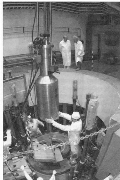
Разгрузка зоны реактора ИБР-2, 2007 год.
