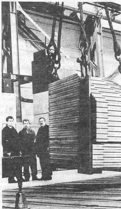
Минск. По заказу Национального центра физики частиц и физики высоких энергий на государственном предприятии «Минский завод имени Октябрьской революции» изготавливается прототип calorimetра установки CMS. Белорусская сторона оплачивает изготовление оборудования из средств долевого взноса в ОИЯИ.
