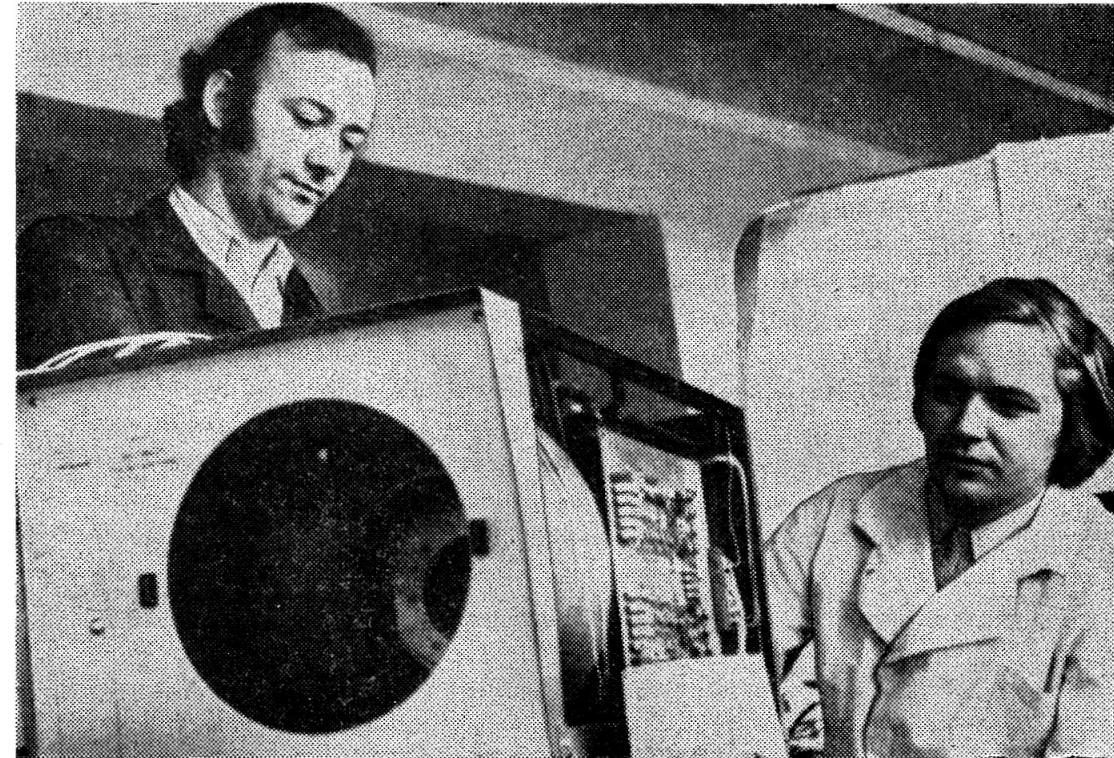
На Опытном производстве ведется изготовление опытного образца дисплея для Лаборатории вычислительной техники и автоматизации. Подобные приборы имеют большое значение для обработки результатов физических исследований. Дисплей позволяет визуально наблюдать за решением задачи на ЭВМ, вносить изменения, исправления на отдельных этапах процесса решения.
