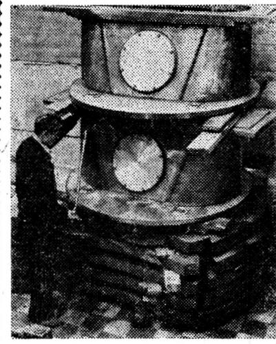
Сpirальные секторные накладки и переходные патрубки вакуумных насосов циклотрона У-400, сделанные в ЦЭМ, полностью подготовлены к монтажу.
