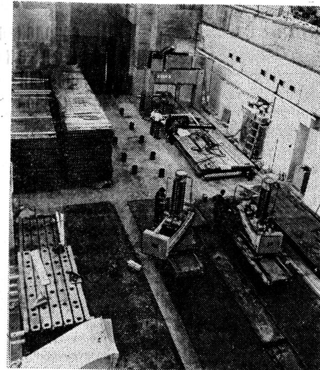
В зале ускорителя здания 131 Лаборатории ядерных реакций ведутся работы по созданию остова электромагнита циклотрона У-400.
