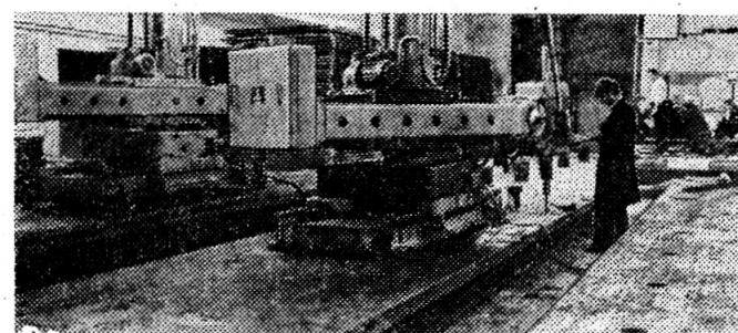
В зале ускорителя У-400 ведется обработка стальных листов перед сваркой и сборкой их в балки остова электромагнита.
