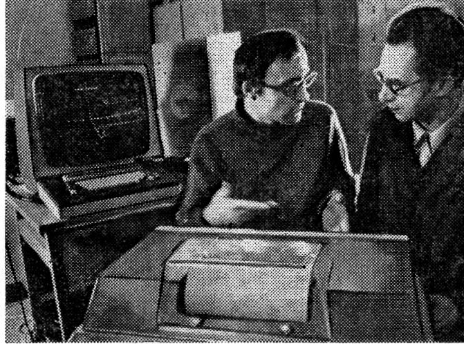
Установка СКМ-200 оснащается ЭВМ ТРА-1 венгерского производства с наиболее полным в Объединенном институте ядерных исследований комплектом внешних устройств. На базе этой ЭВМ развивается система контроля параметров установки, что дает возможность проводить физические эксперименты на современном научно-техническом уровне.
