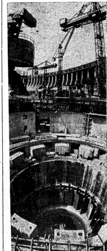
**ЗАПОРЬЖЕ.** На строительстве ДнепроГЭС-2 началась установка камеры рабочего колеса первой гидротурбины. Выполнение обязательство — ввести в конце года в действие не два, как намечалось по плану, а три гидроагрегата, — днепростроевцы все монтажные работы ведут с опережением графика.
