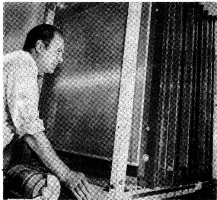
На снимке: руководитель группы ОЭФА Ю. В. Куликов проводит осмотр изготовленных под его руководством в отделе эксплуатации физической аппаратуры ЛВЭ ОИЯИ 40 штук искровых камер размером 1 м х 1 м для установки «Фотон».
