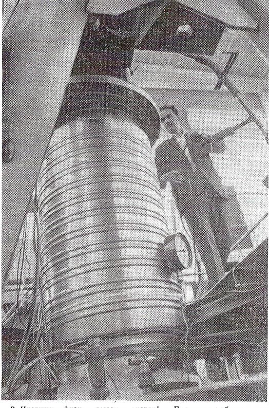
В Институте физики высоких энергий в Протвино работает одна из базовых установок ОИЯИ — двухметровая водородная пузырьковая камера «Людмила». Большой вклад в ее создание вложен сотрудниками отдела водородных камер Лаборатории высоких энергий Объединенного института. На прошедшей конференции по физике высоких энергий в Батавии были доложены первые результаты, полученные на этой установке.
