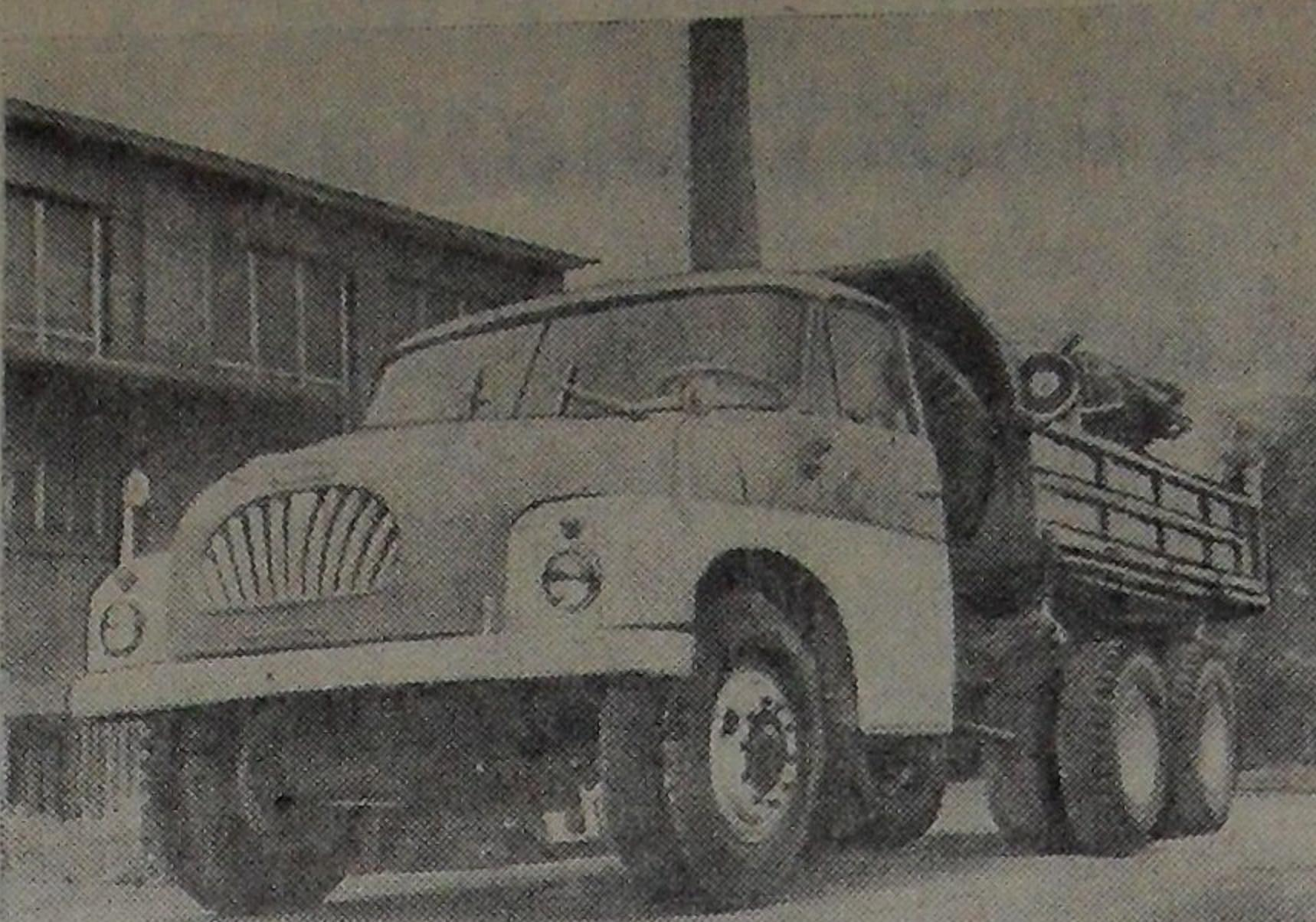
В Чехословацкой Социалистической Республике выпущен новейший тип автомобиля «Татра-138». Он предназначен для перевозки грузов до 12 тонн. У него, как и у других грузовиков «Татра», воздушная система охлаждения, благодаря которой автомобили этой марки в настоящее время не имеют себе равных в работе при особо тяжелых эксплуатационных условиях — в тропиках, гористой местности и в заполяре.
